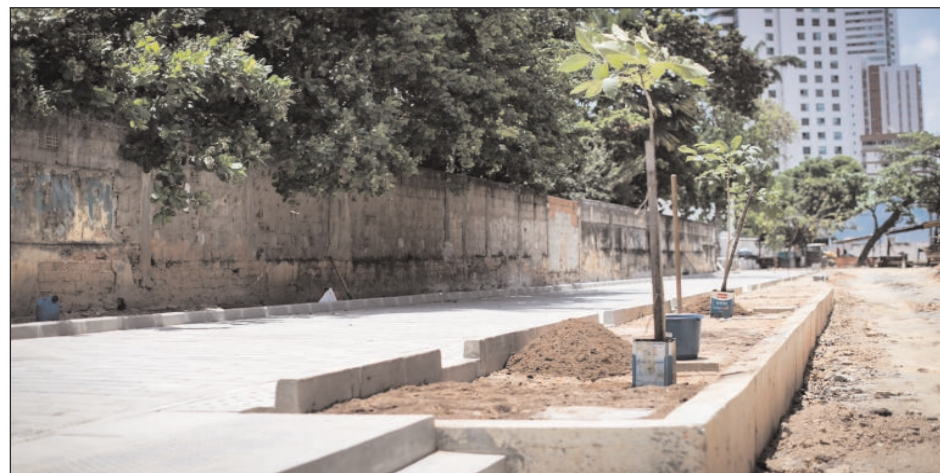
Com as obras iniciadas em março deste ano, o Parque das Graças está sendo instalado às margens do Rio Capibaribe, entre as pontes da Torre e da Capunga
