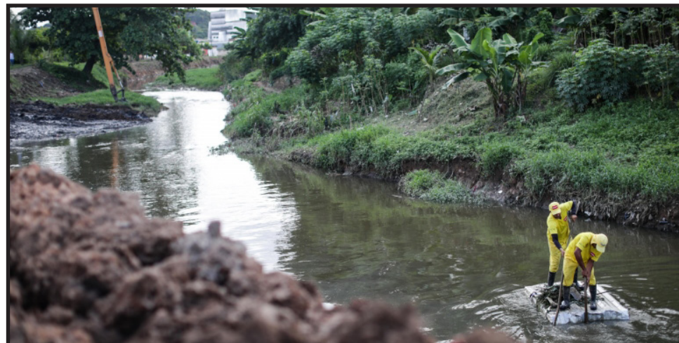
Serviço iniciado pela Emlurb em janeiro deste ano já concluiu 33 canais e outros 12 estão em andamento.
